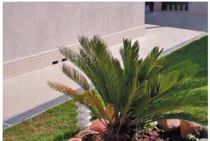
Calçada revestida com Ladrilho Hidráulico 25 dados ao redor da casa, funcionando como barreira de entrada de sujeira, autolimpante, antiderrapante, atérmica e para autotráfego.
