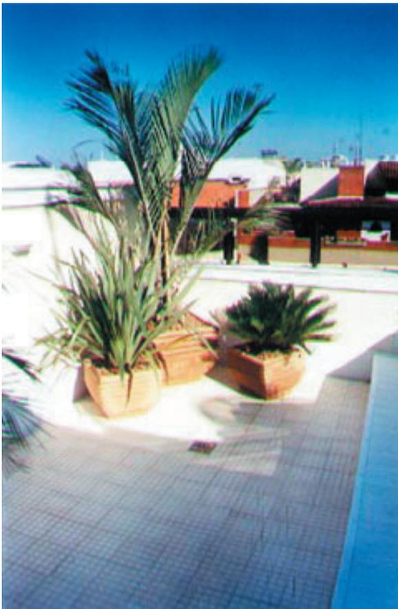
Pisos 25 dados 20x20 cm, na cor Branco Diamante nº 32, sendo utilizado em área externa de piscina, rejuntado com rejunte tipo extra e resinado com procedimento específico para baixa manutenção, alto tráfego e baixo acúmulo de calor.
