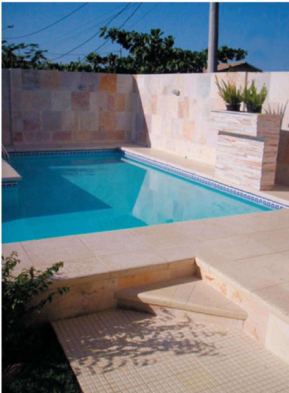
Piso 25 dados, 20 x 20 cm, na cor Amarelo Pantone, em calçada ao redor de piso e bordas de piscina Atérmicas Limestone Texturizado, 50 x 50 cm, na cor Yellowish. Pisos impermeabilizados com sistema Limestone.
