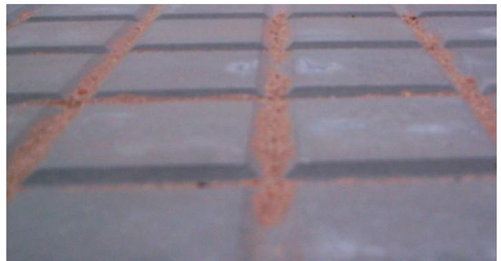
Detalhe de calçada construída com piso 25 Dados, evidenciando a captação de sujeira que será removida facilmente com água da chuva, de limpeza ou com a vassoura.
